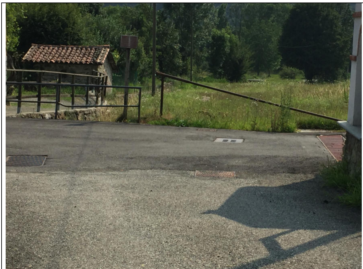
Foto n.2 – Veduta verso valle all'altezza del sottoservizio di Via Marconi . Si osserva come la pendenza del piano di campagna della destra idrografica tenda a convergere verso il Rio ( in alto a sinistra)
