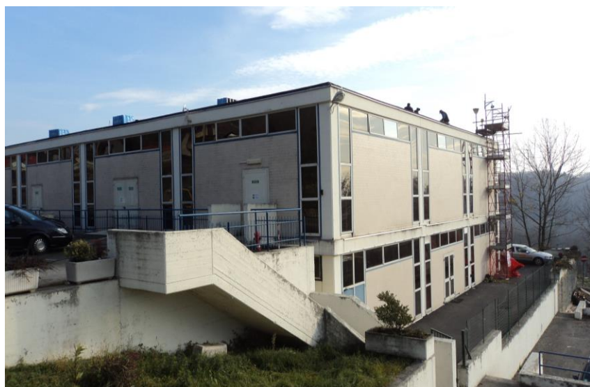
Esempio di ponte di accesso
