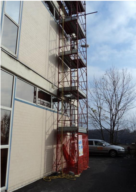
Esempio di ponte di accesso
